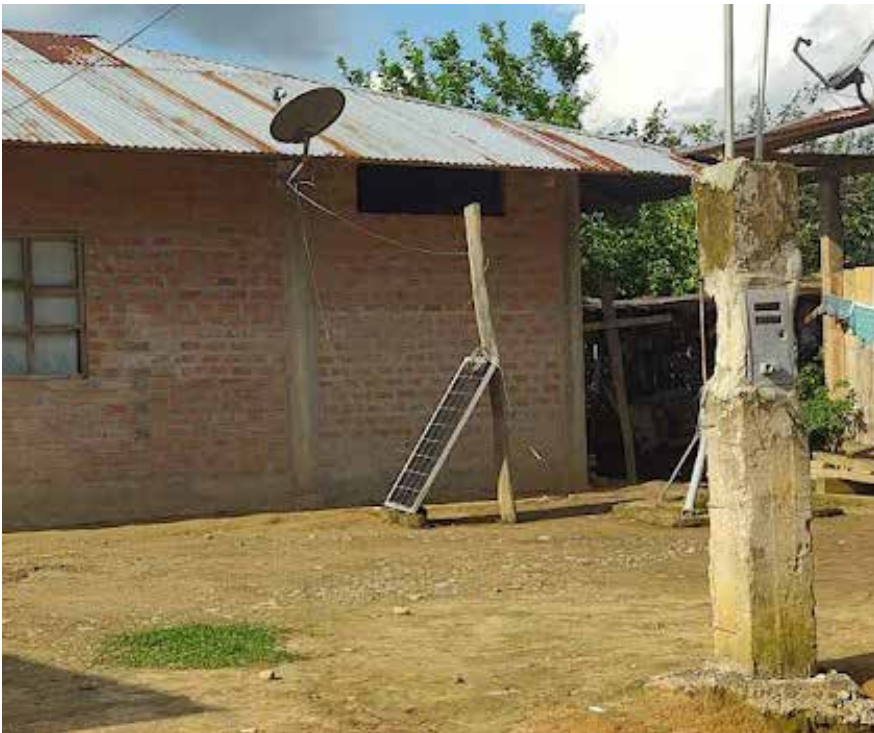
Figura 14. Módulo fotovoltaico orientado al oeste con una inclinación de 50° (a las 16 horas). Tiene poca captación en el día por la incorrecta orientación
