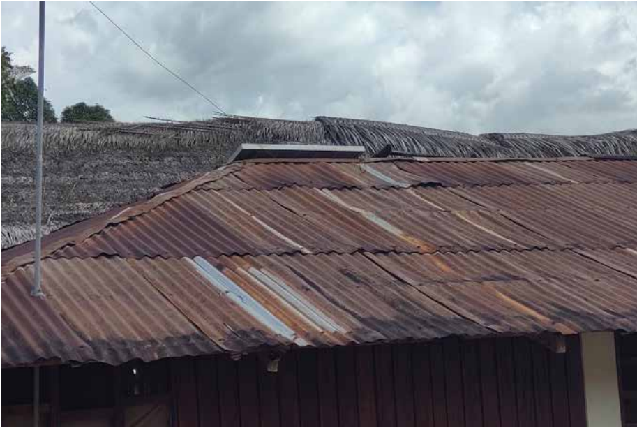
Figura 16. Uso de cables mellizos para la conexión al controlador ubicado a 15 metros. Cable expuesto a la alta temperatura de la calamina en días soleados y a potenciales cortes debidos al borde afilado
