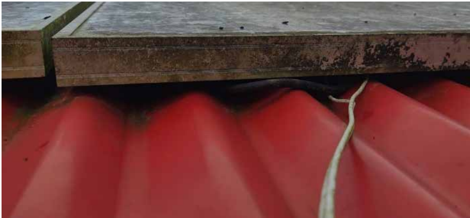
Figura 16. Uso de cables mellizos para la conexión al controlador ubicado a 15 metros. Cable expuesto a la alta temperatura de la calamina en días soleados y a potenciales cortes debidos al borde afilado
