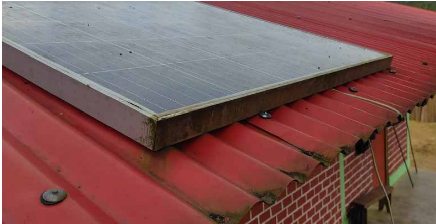
Figura 14. Módulo fotovoltaico orientado al oeste con una inclinación de 50° (a las 16 horas). Tiene poca captación en el día por la incorrecta orientación
