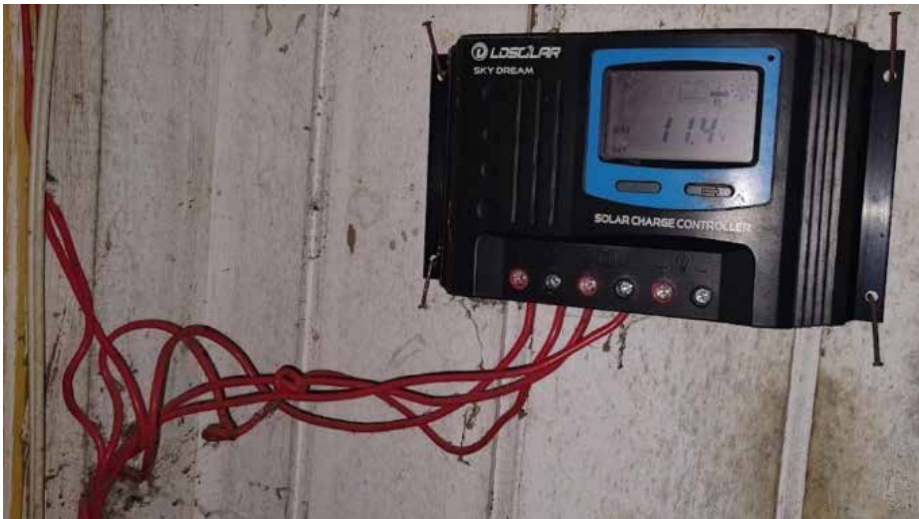
Figura 18. Controlador sin caja de protección y cableado expuesto
