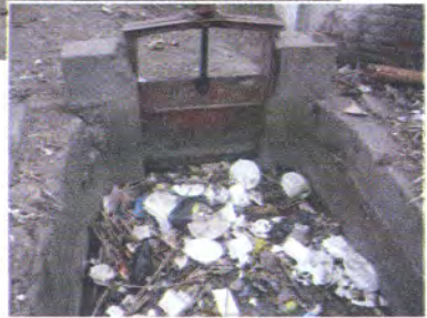
Canal de Regadío
